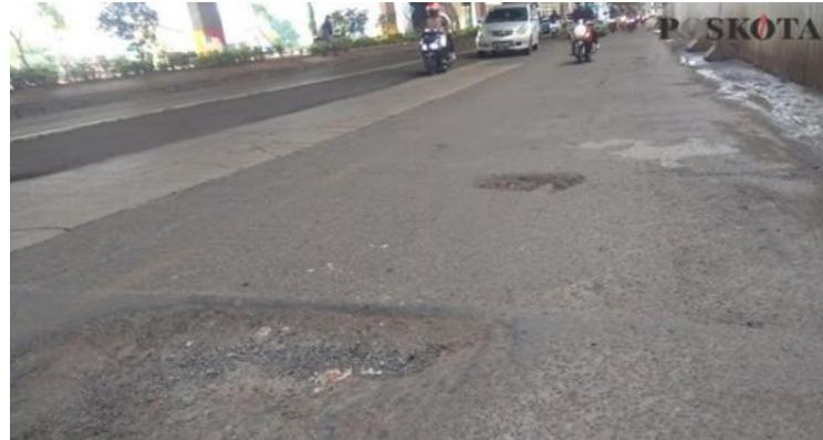
Gambar 3. Jalan Tanpa Marka Garis
