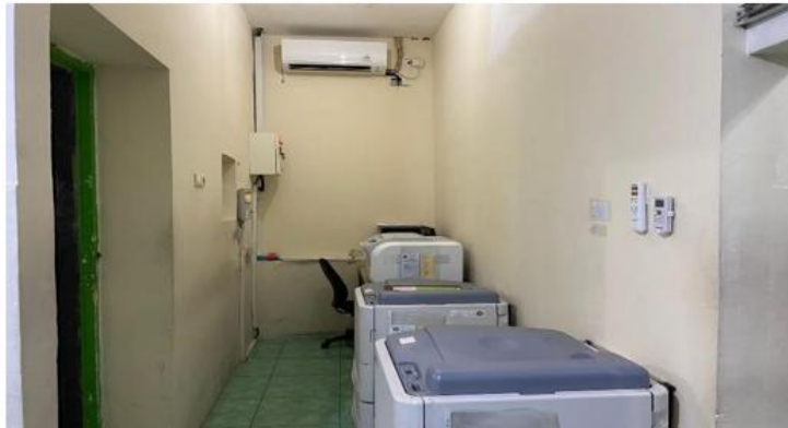
Gambar 12. Ruang Komputer (Instalasi Radiologi RSI Siti Aisyah Madiun, 2024)
